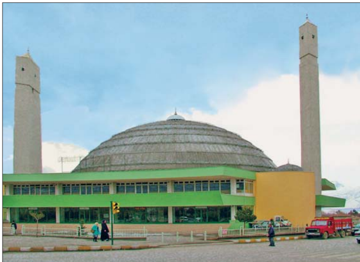
Terzi Baba Camii ve Külliyesi – Erzincan
